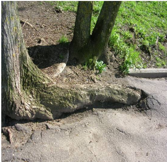
Мал.5.4.1. – Узняты карэннем асфальт тратуара на Нямізе ў Мінску і разбурэнні палацавага комплексу ў Вялікай Ліпе
