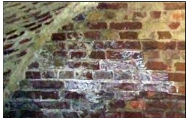
Мал. 4.2.6. – Міцэлій S. lacrymans : шнуры пад ДВП; на цагляным скляпенні
