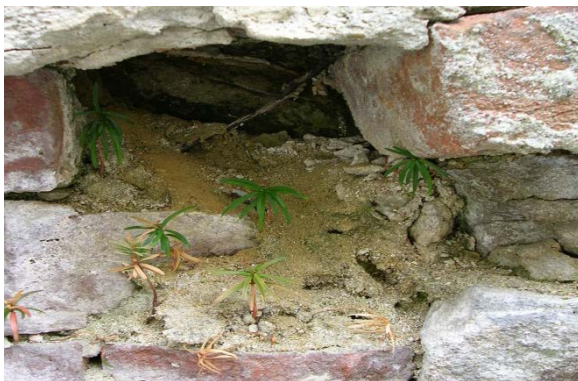
Мал.5.4.1. – Узняты карэннем асфальт тратуара на Нямізе ў Мінску і разбурэнні палацавага комплексу ў Вялікай Ліпе
