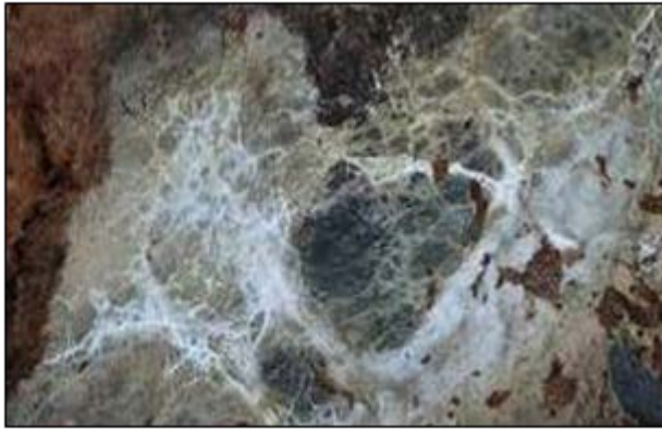
Мал. 4.2.6. – Міцэлій S. lacrymans : шнуры пад ДВП; на цагляным скляпенні
