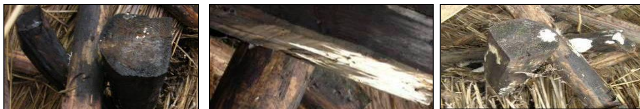
Мал. 4.2.10. - Развіцце Coniophora puteana на апрацаванай драўніне кроквеннай канструкцыі пры затрымцы рамонтных прац
