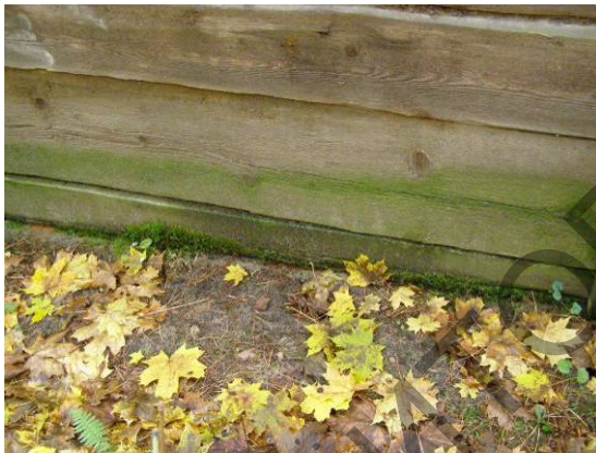
Рис.4.21. Подмокание сруба из-за подсыпки и отскока дождевой воды от почвы (Сектор «Жамойтия»)
