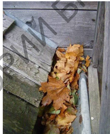
Рис.4.10. Забившийся листьями водоотвод (сектор «Местечко», лекционный дом)
