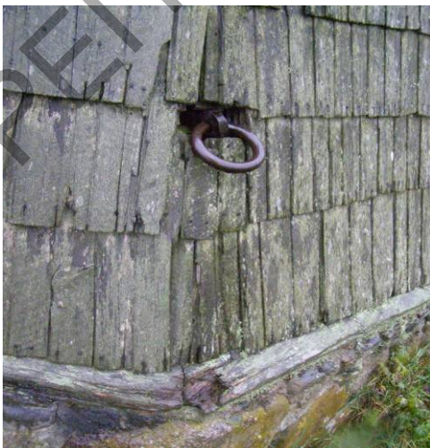
Рис.4.23. Постоянное увлажнение угла
