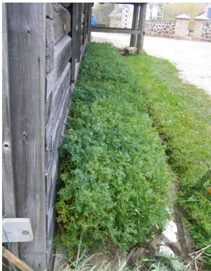
Рис.4.9. Очень близко подступающая высокая растительность, препятствующая вентиляции (сектор «Местечко», дом)
