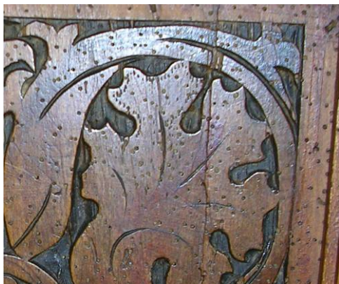
Малюнак 3.3.4 – Зашпакляваныя старыя лётныя адтуліны мэблевага тачыльшчыка
